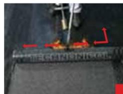
La superficie debe estar limpia de polvo, escombros, grasa, hojas, sin agujeros, grietas u otras irregularidades. La superficie debe estar tratada con imprimación antes de la instalación del material impermeabilizante.
